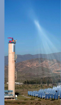
Plataforma Solar de Almería
