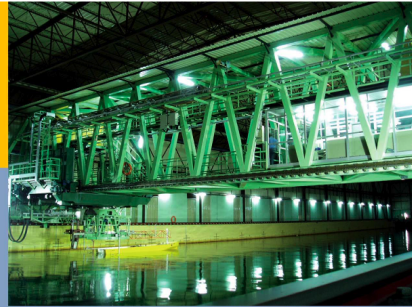
Canal de Experiencias Hidrodinámicas de El Pardo
